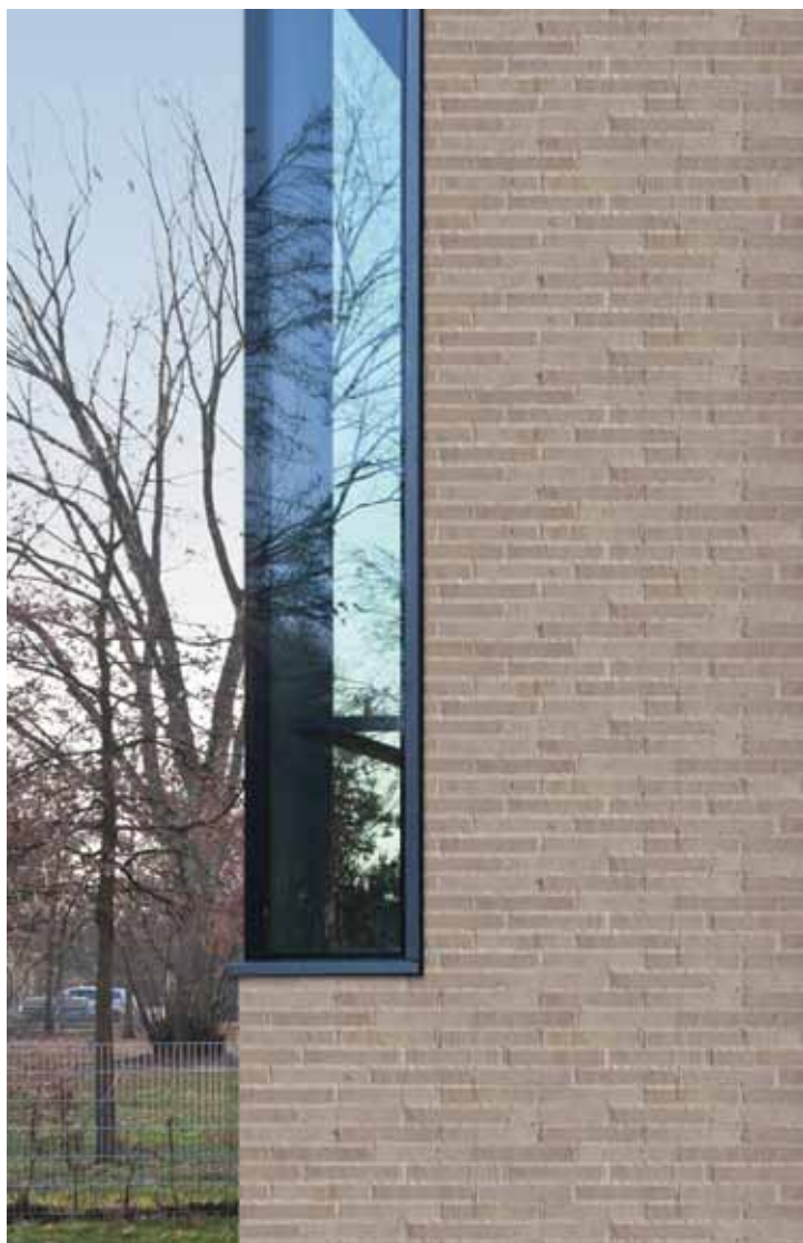
36102 aquaterra Vesuvgrau 365 x 115 x 52 mm Fugmörtel + heller Splitt, Körnung 1,8–3 mm
