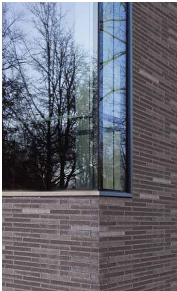
36101 aquaterra Rauchschwarz 365 x 115 x 52 mm Fugmörtel + dunkler Splitt, Körnung 1,8–3 mm
