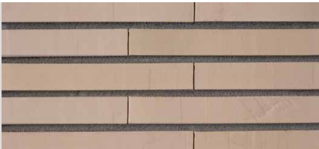
dunkle Lagerfuge im Kontrast, ohne Stoßfuge
