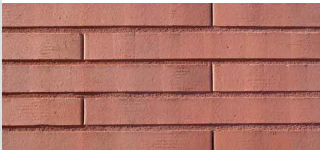
rote Lagerfuge, ohne Stoßfuge, Langformat
