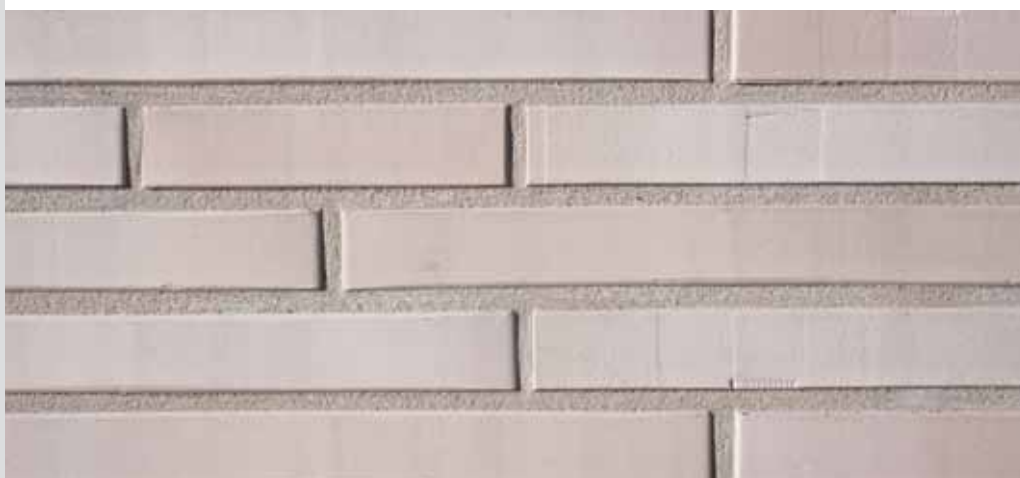
Klinker und Fuge im Farbbild angeglichen
